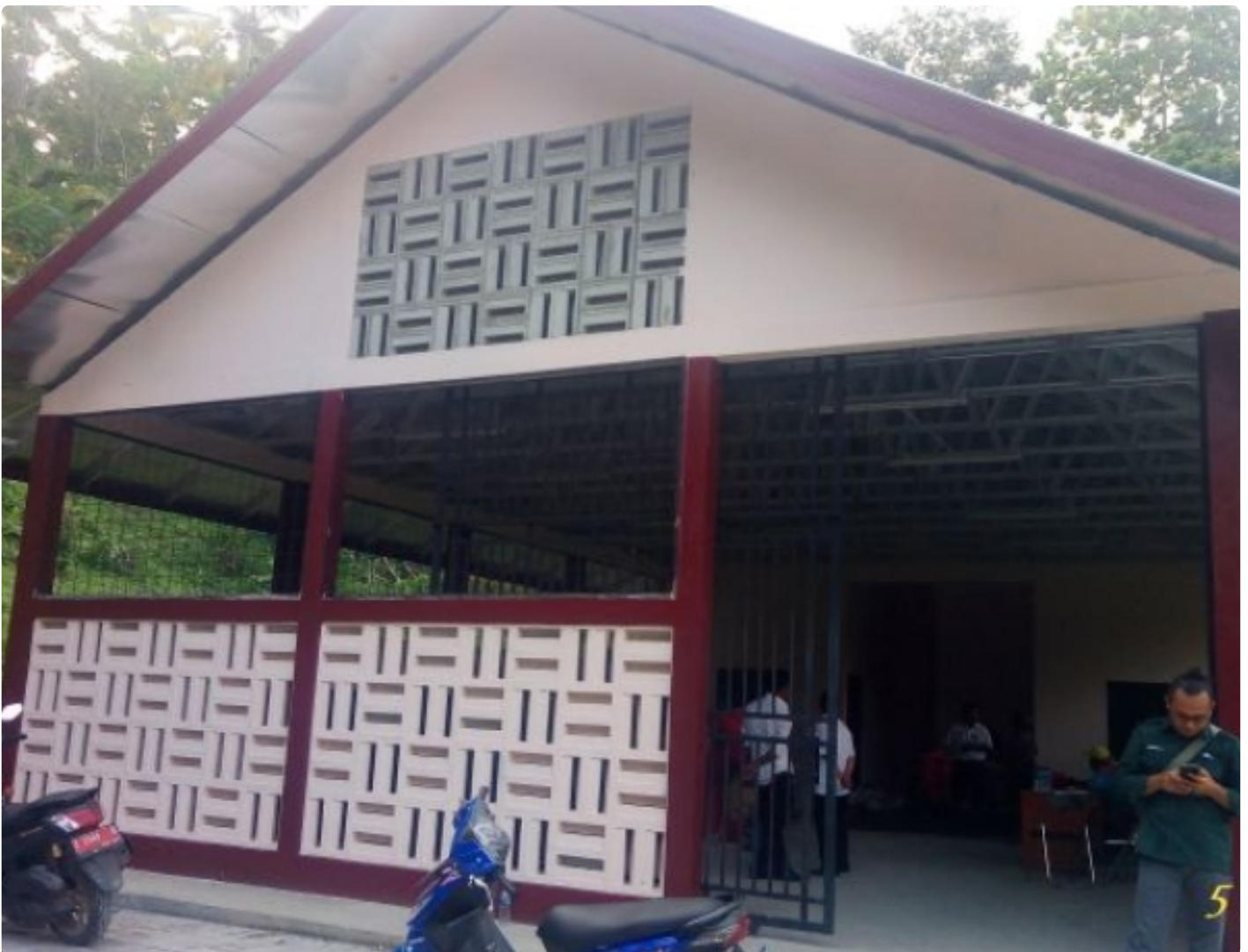
Bangunan Lokasi TPS3R di Dusun Bengkekan Desa Sukahurip Kecamatan Pangandaran. (Photo oleh : MISG/nang surya)
